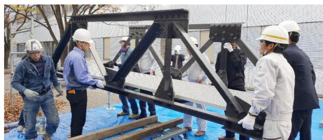
図2 FRP形材を用いたデモ橋梁
