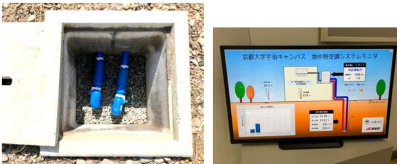
図5 地下に埋設した地中熱交換器（長さ100 m、左）と地中熱空調システムの運転状況モニター（右）
